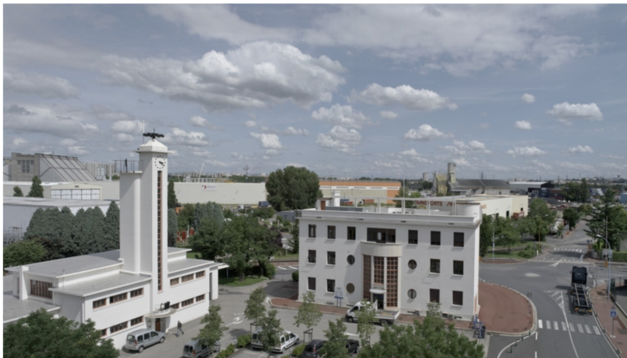
Vue d'ensemble ouest des bâtiments adminstratifs de la CNR datant des années 1930
