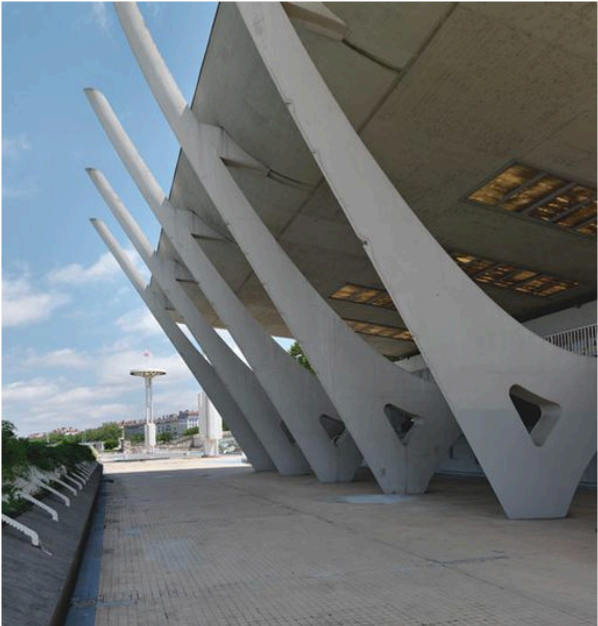
Détail du soubassement du bâtiment d'exploitation (état juin 2012).
