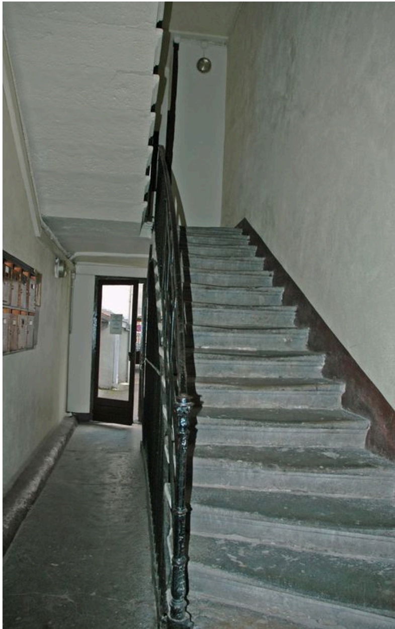
Première volée en pierre de la cage d'escalier vue depuis l'est
