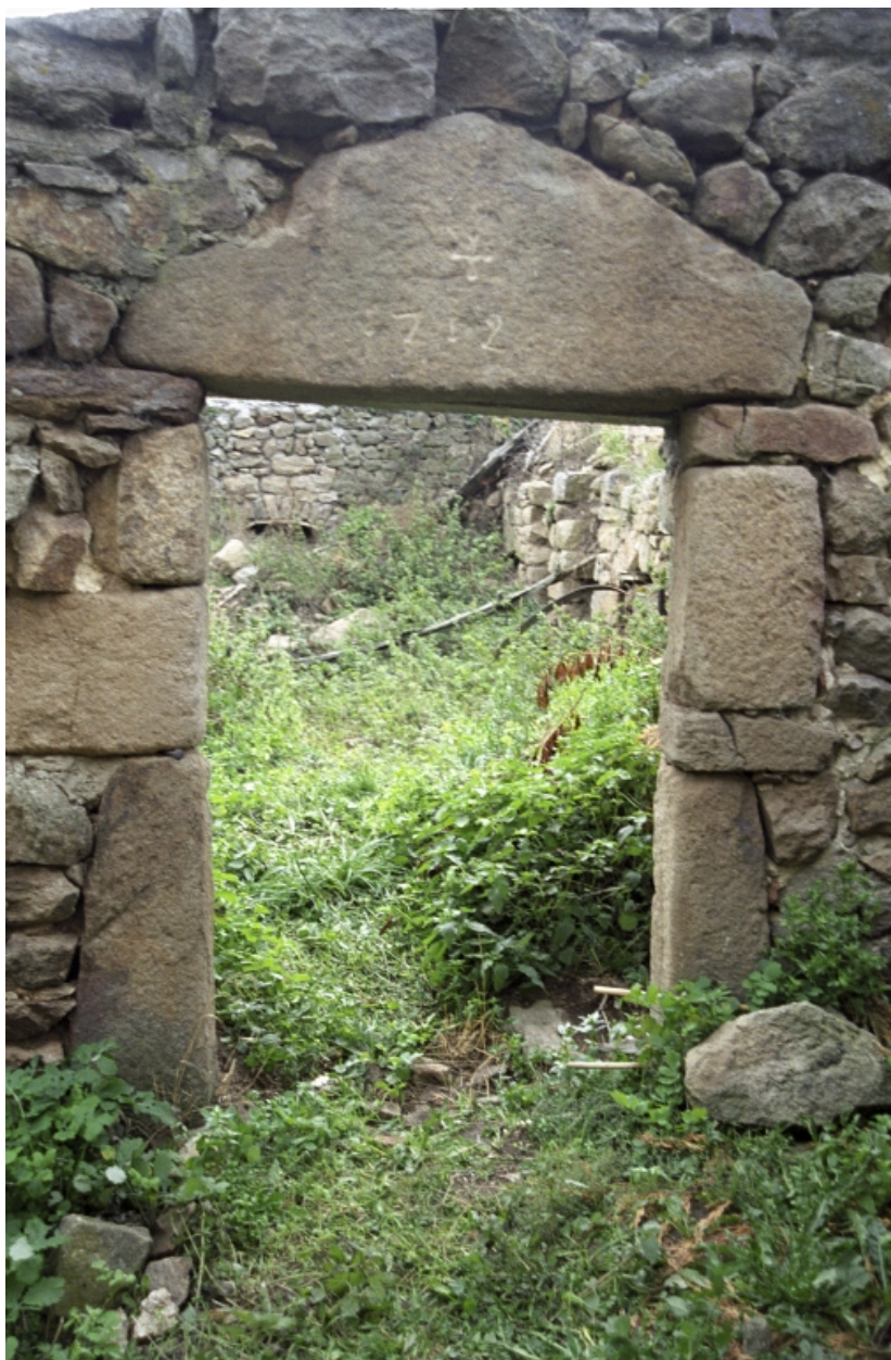
Ferme à Eculieux (B4 986), Détail d'un encadrement de baie daté 1712.
