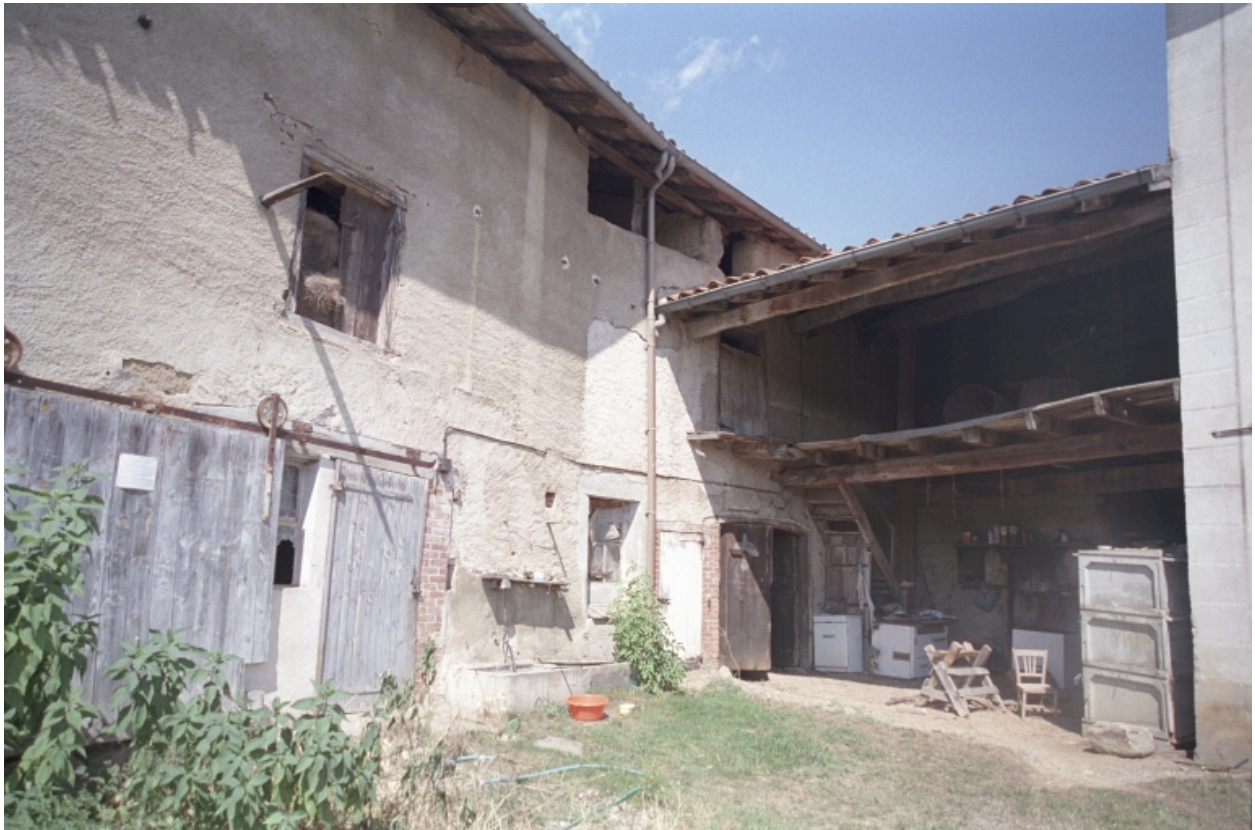
Culé, ferme, vue d'ensemble des communs et du cuvage (1986 A 464).
