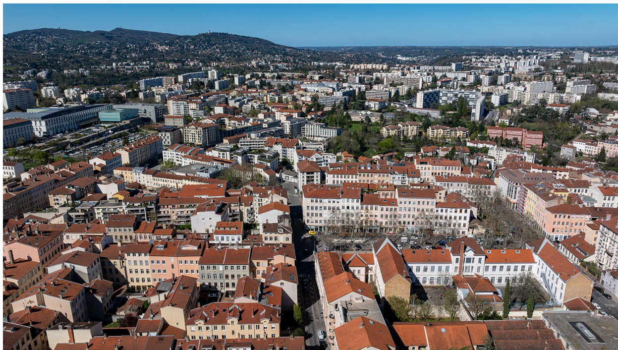
Vue d'ensemble secteur des immeubles-ateliers (vue drone)
