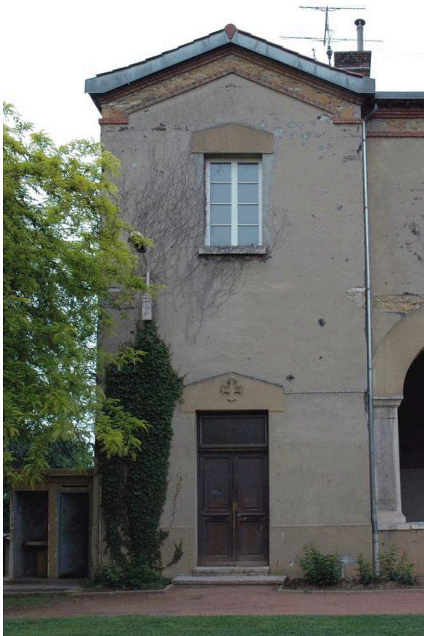
Bâtiment de la galerie, élévation principale, avant-corps ouest
