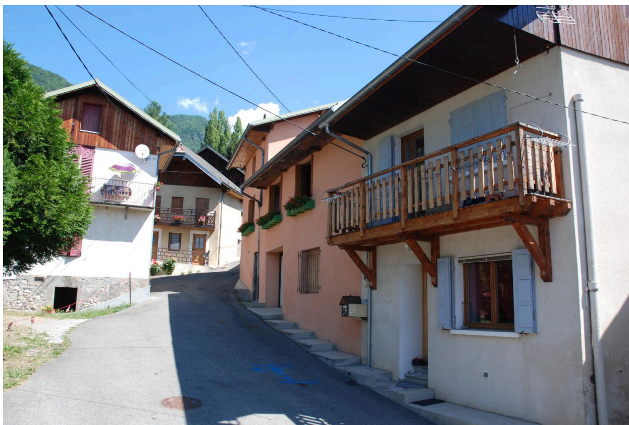
Vue de la montée de l'Ouille, depuis le sud. A droite, maisons de vigneron 2018 H2 613, 614
