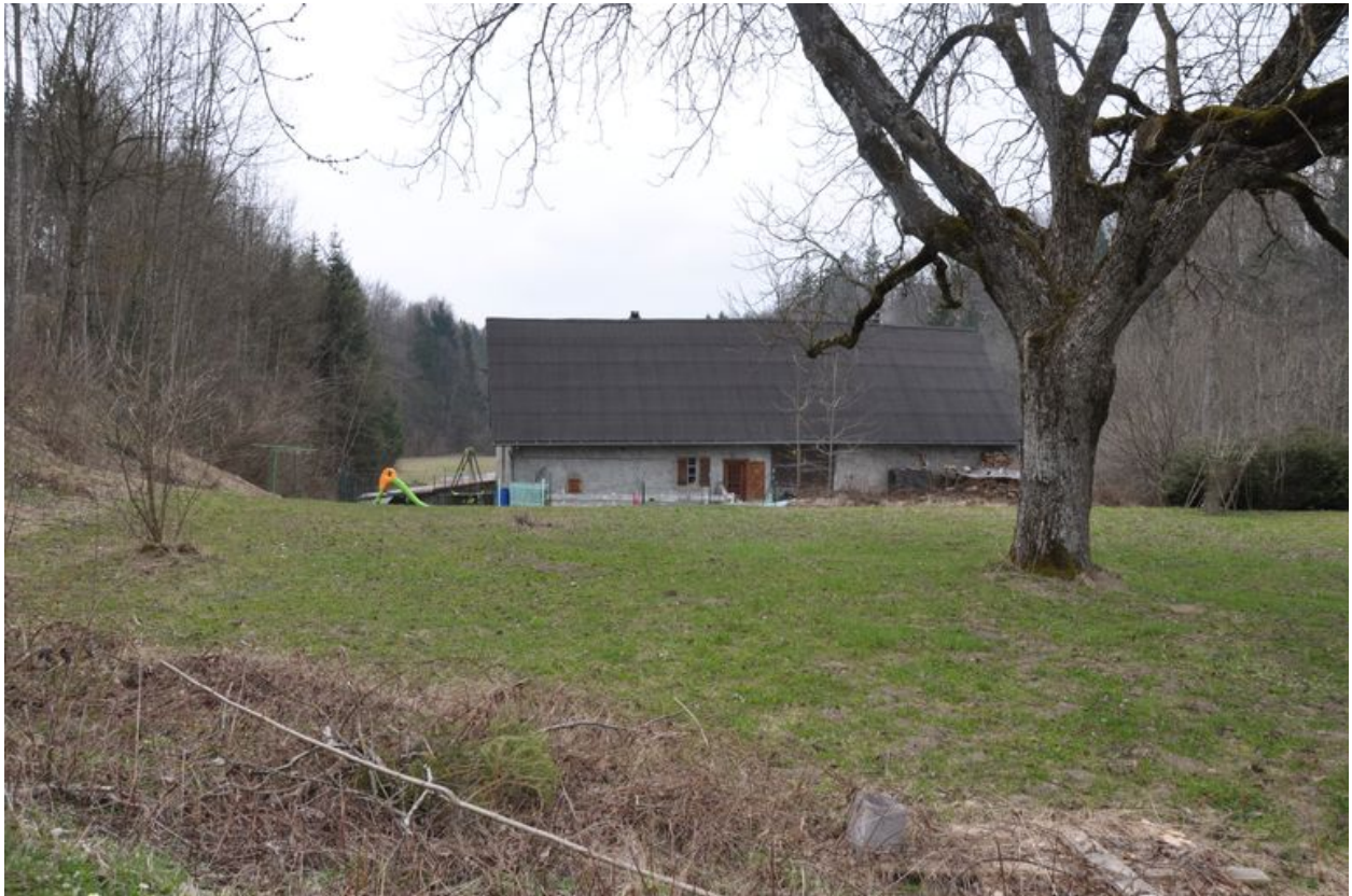
Façade latérale Ouest du bâtiment du moulin
