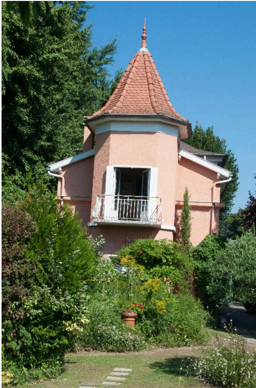
Tour demi-hors-oeuvre sud
