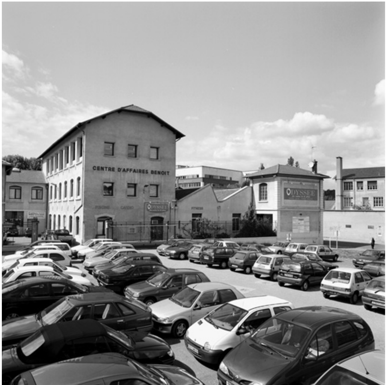
Vue d'ensemble est
