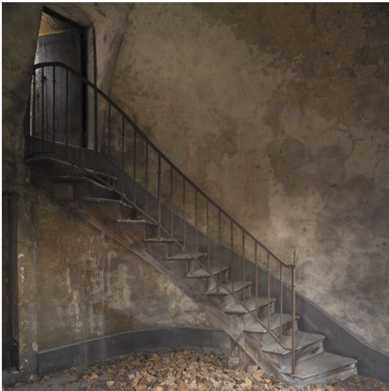
Corps de bâtiment ouest. Tour sud-ouest. 2e étage. L'escalier menant à l'échauguette
