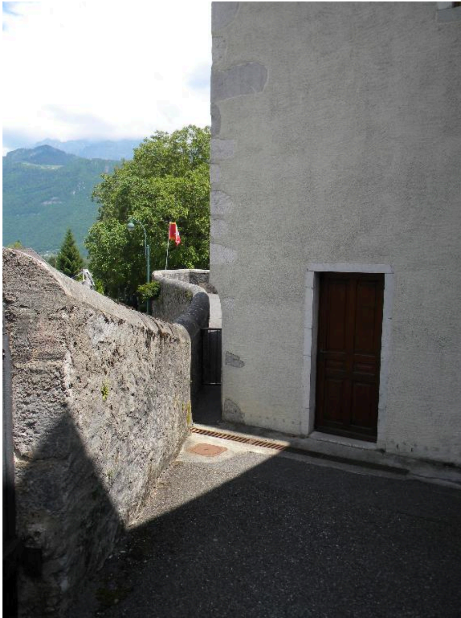
Vue d'un passage dans le chaînage d'angle pour aller à la façade nord.
