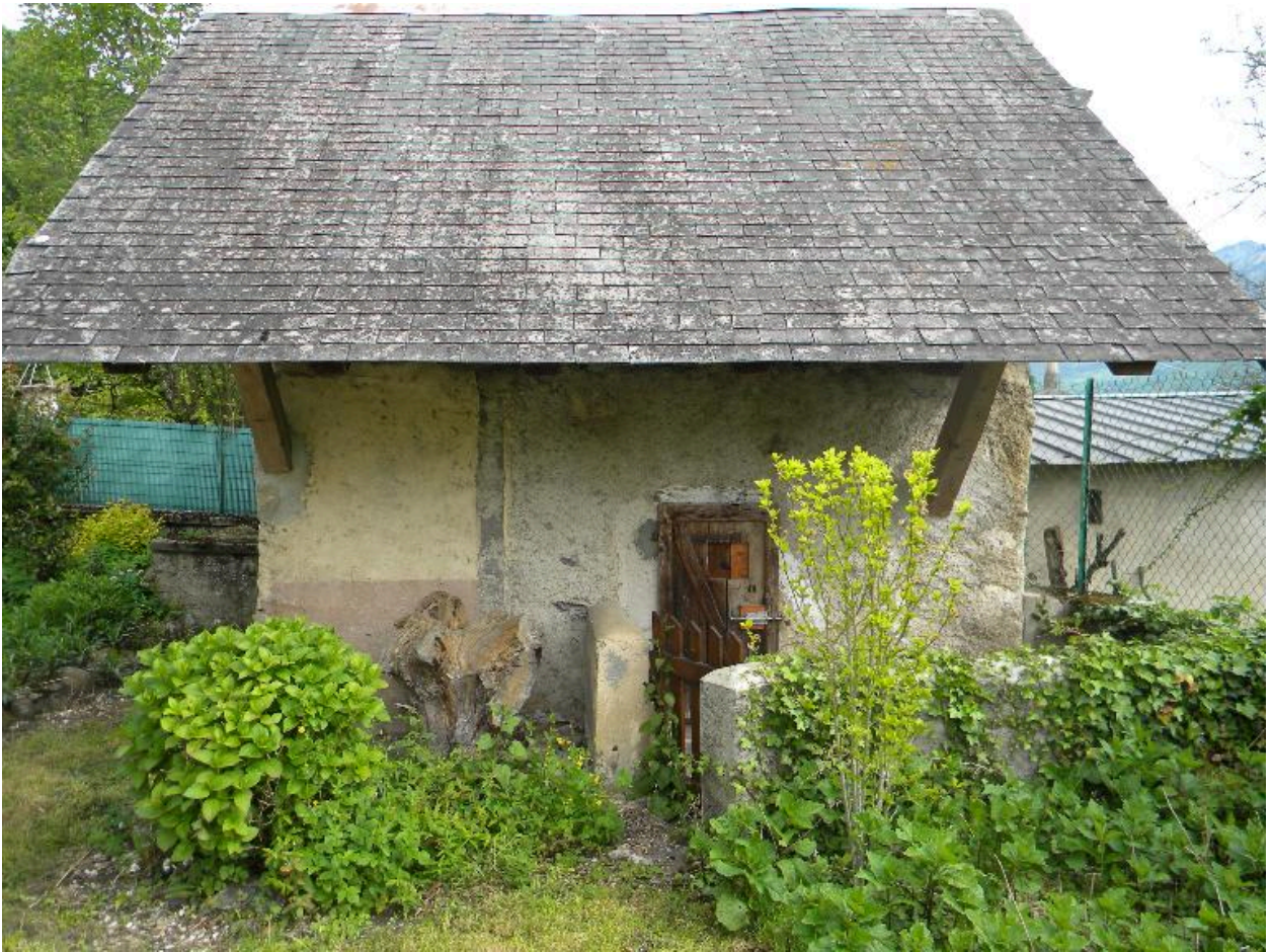
Vue de la façade sud d'une dépendance.
