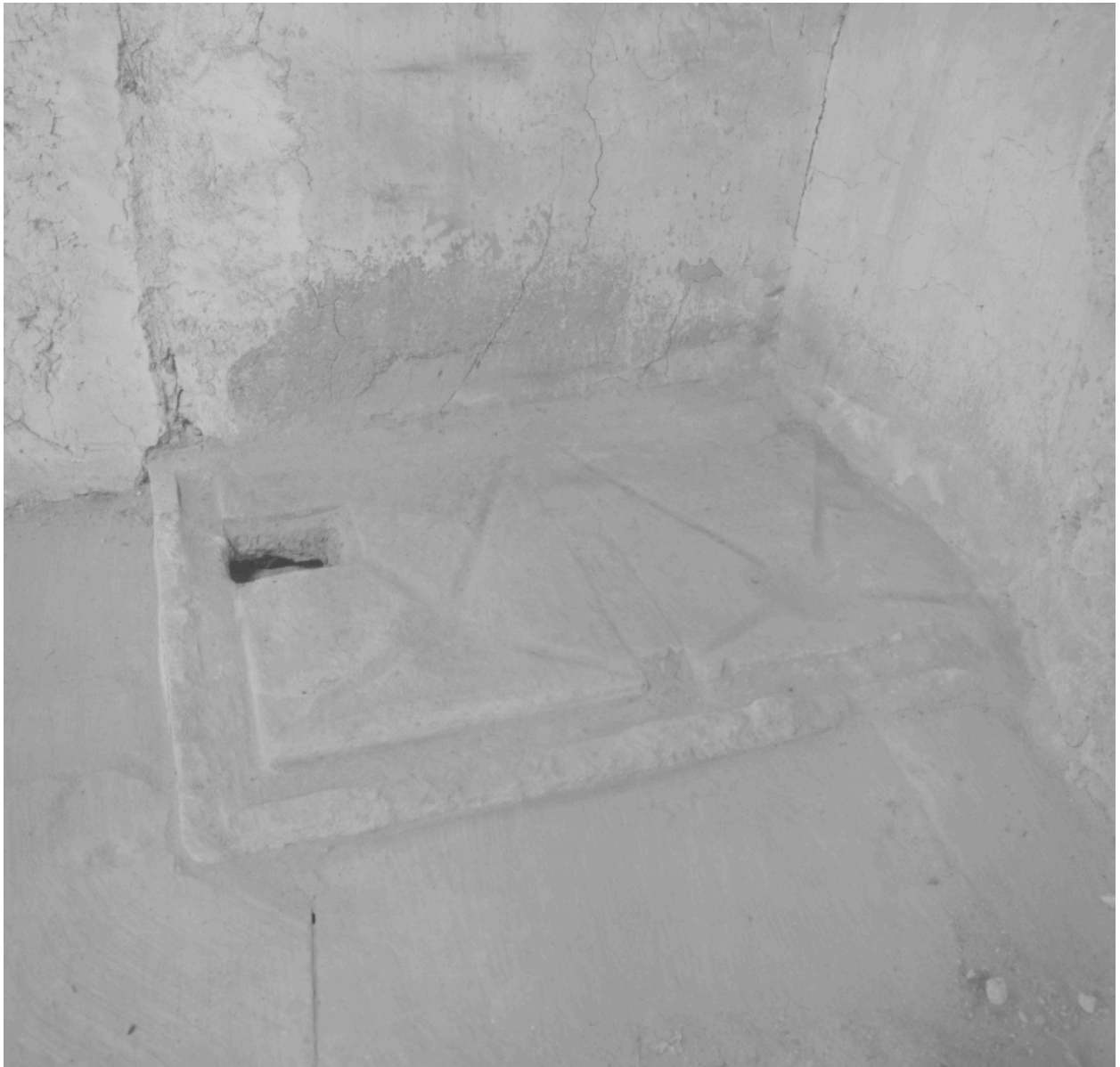
Rue du Coulard, rue de la Poste, maison (AX 100). Caves : dalle de pierre percée permettant l'écoulement du vin vers les cuves.
