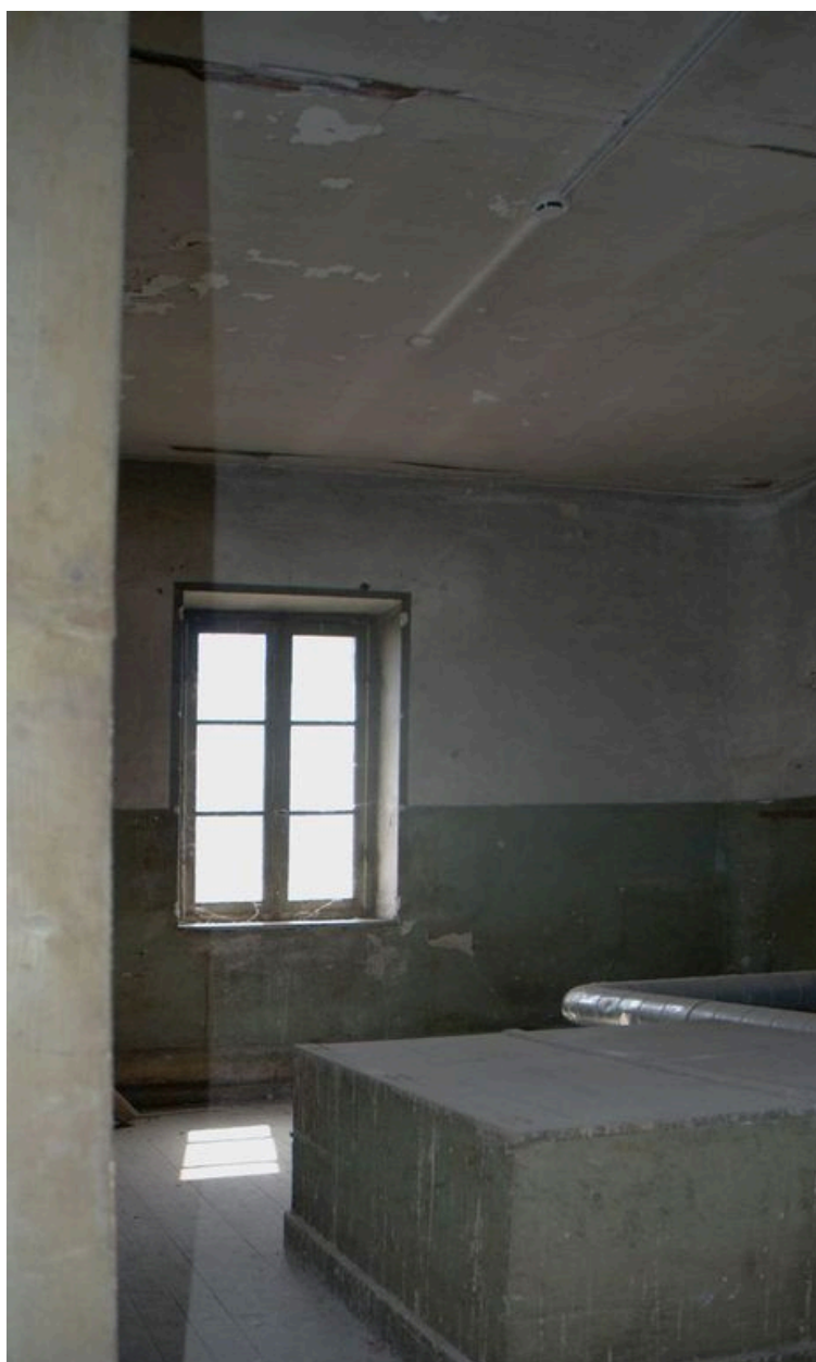
Combles de l'ancien quartier des agitées
