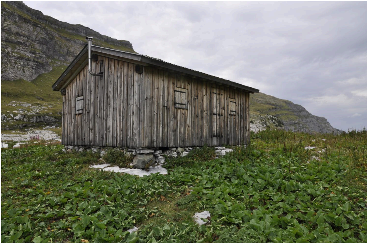
Vue de l'élévation sud-est
