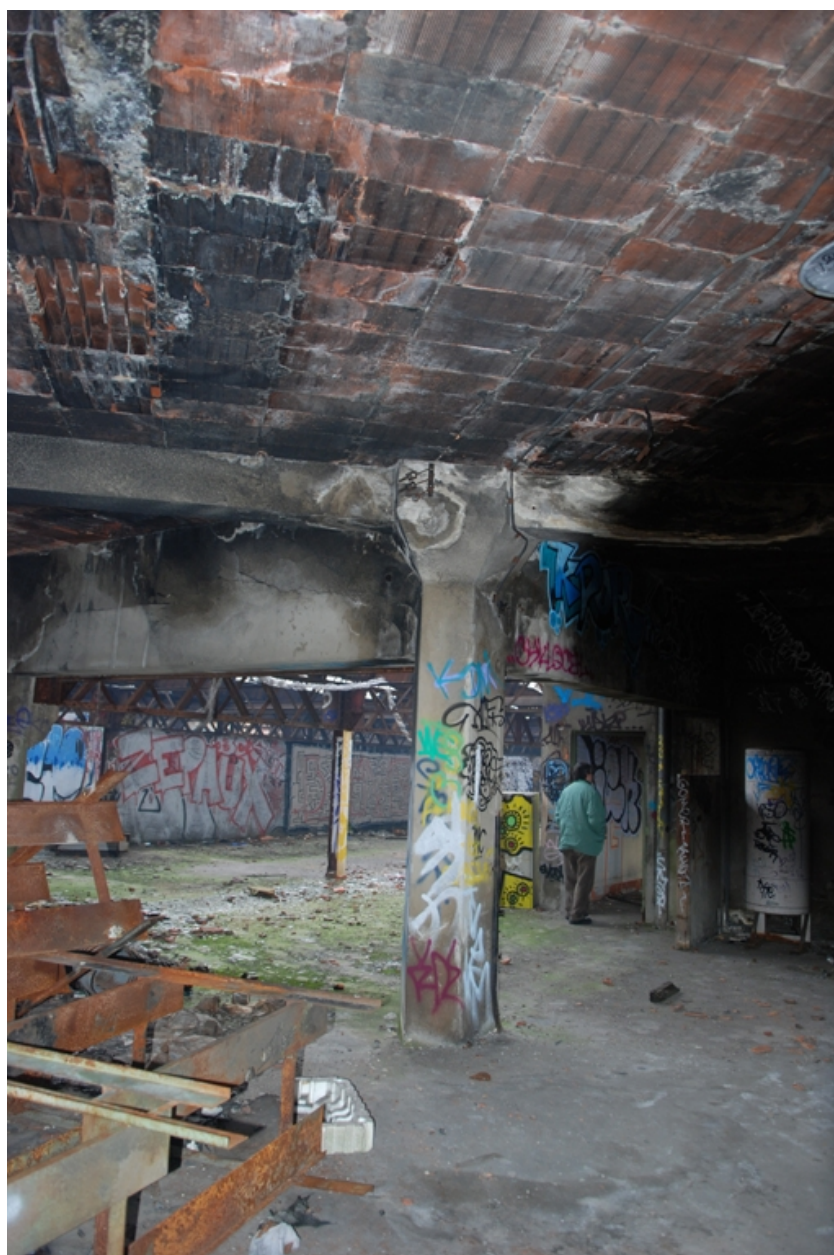
Détail poutre béton centrale
