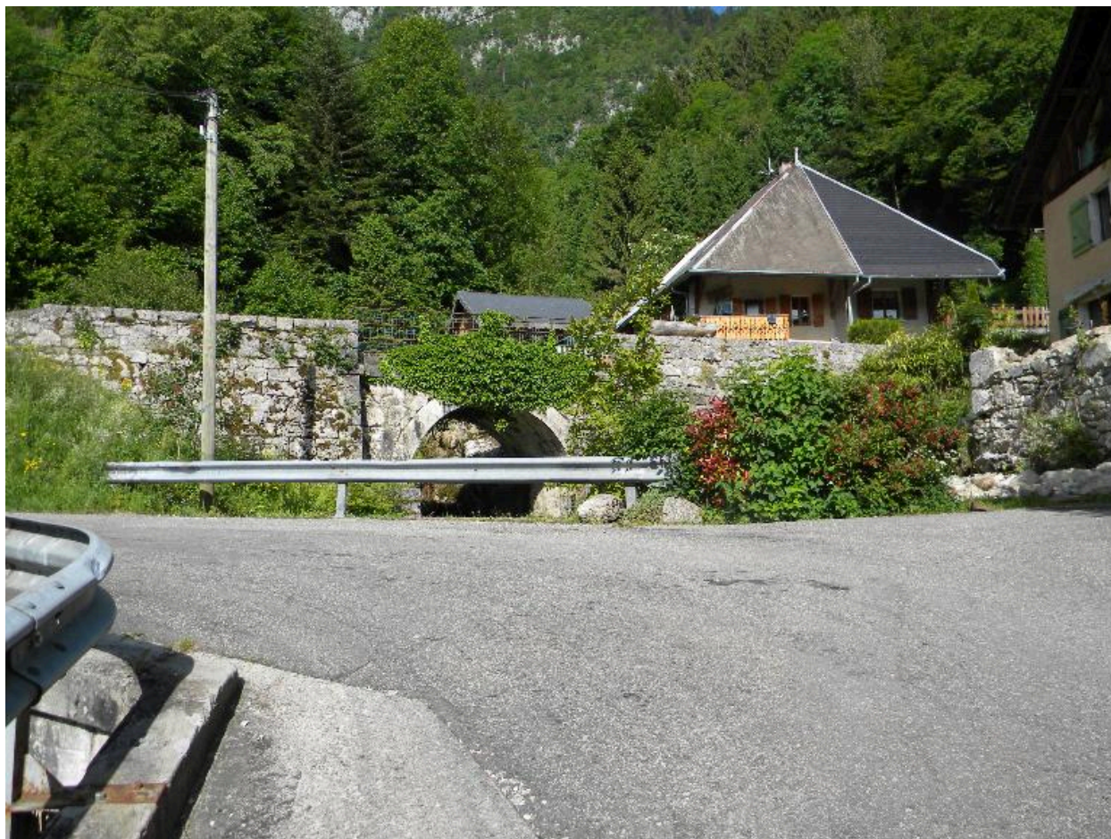
Vue d'un ancien pont au sud du hameau.
