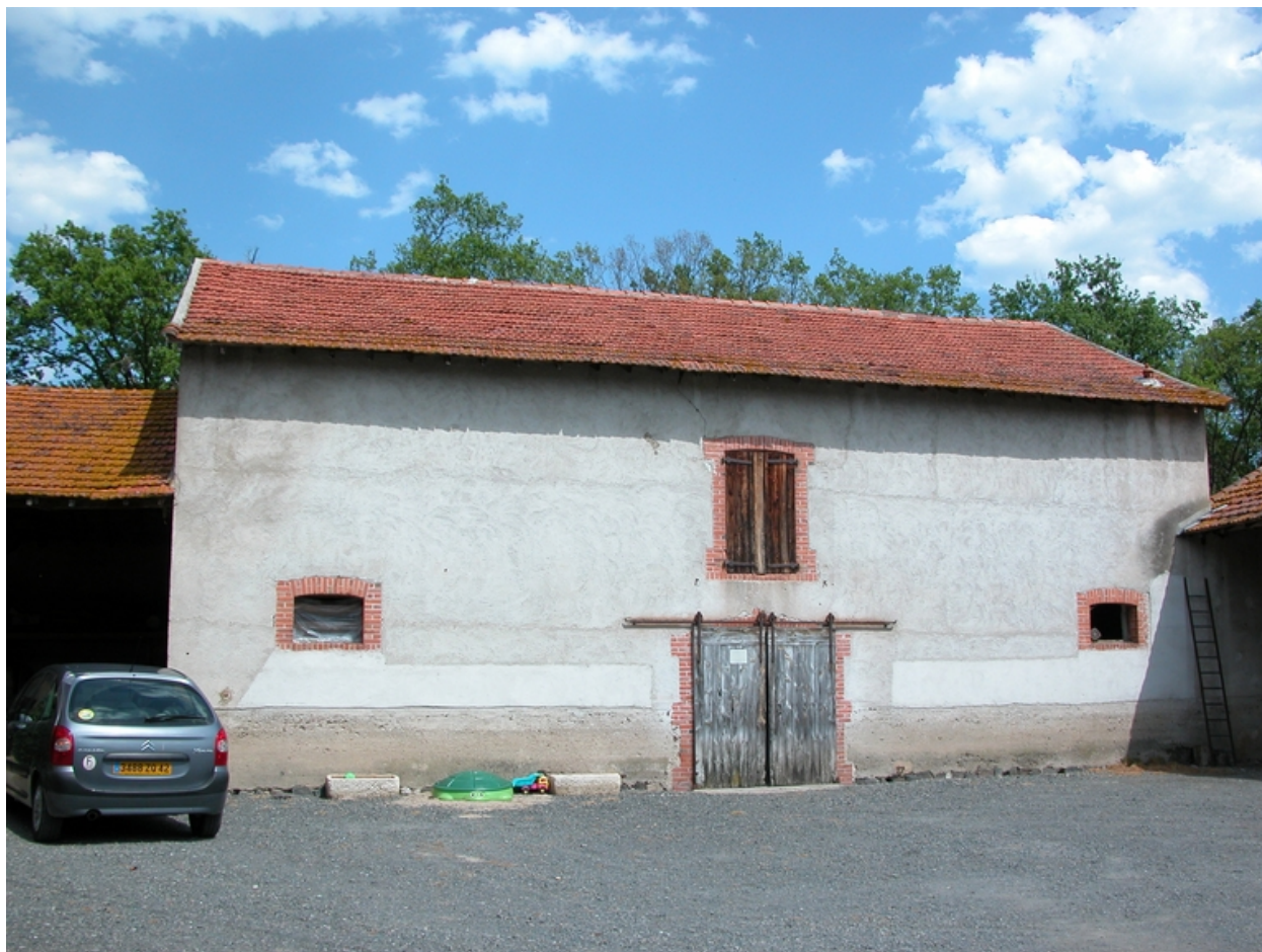
Vue d'ensemble de l'étable.
