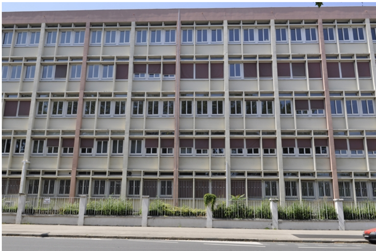
QGF : bâtiment des années 70. Vue prise depuis le boulevard Yves Farges.
