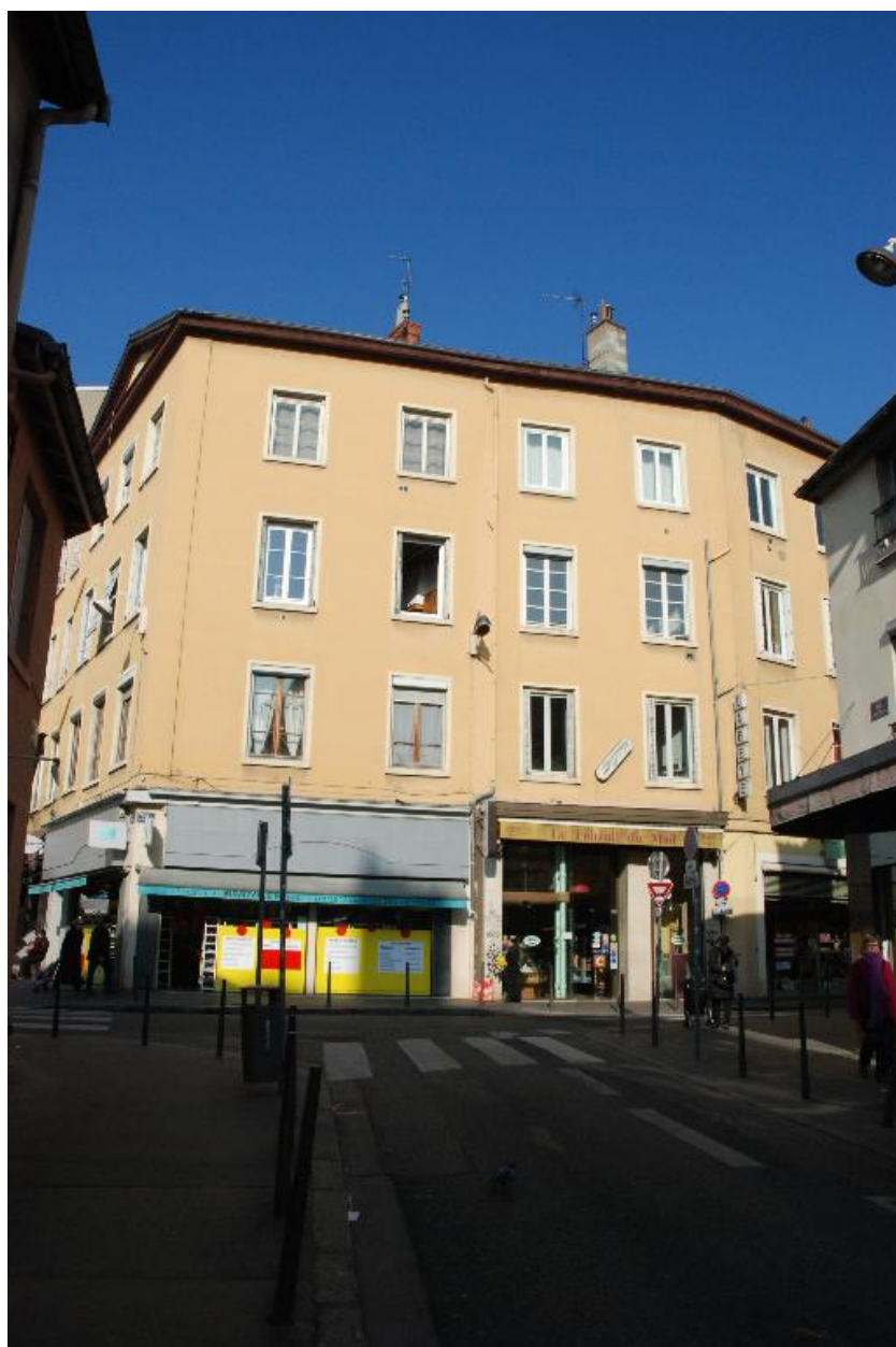
Façade rue du Mail depuis l'est
