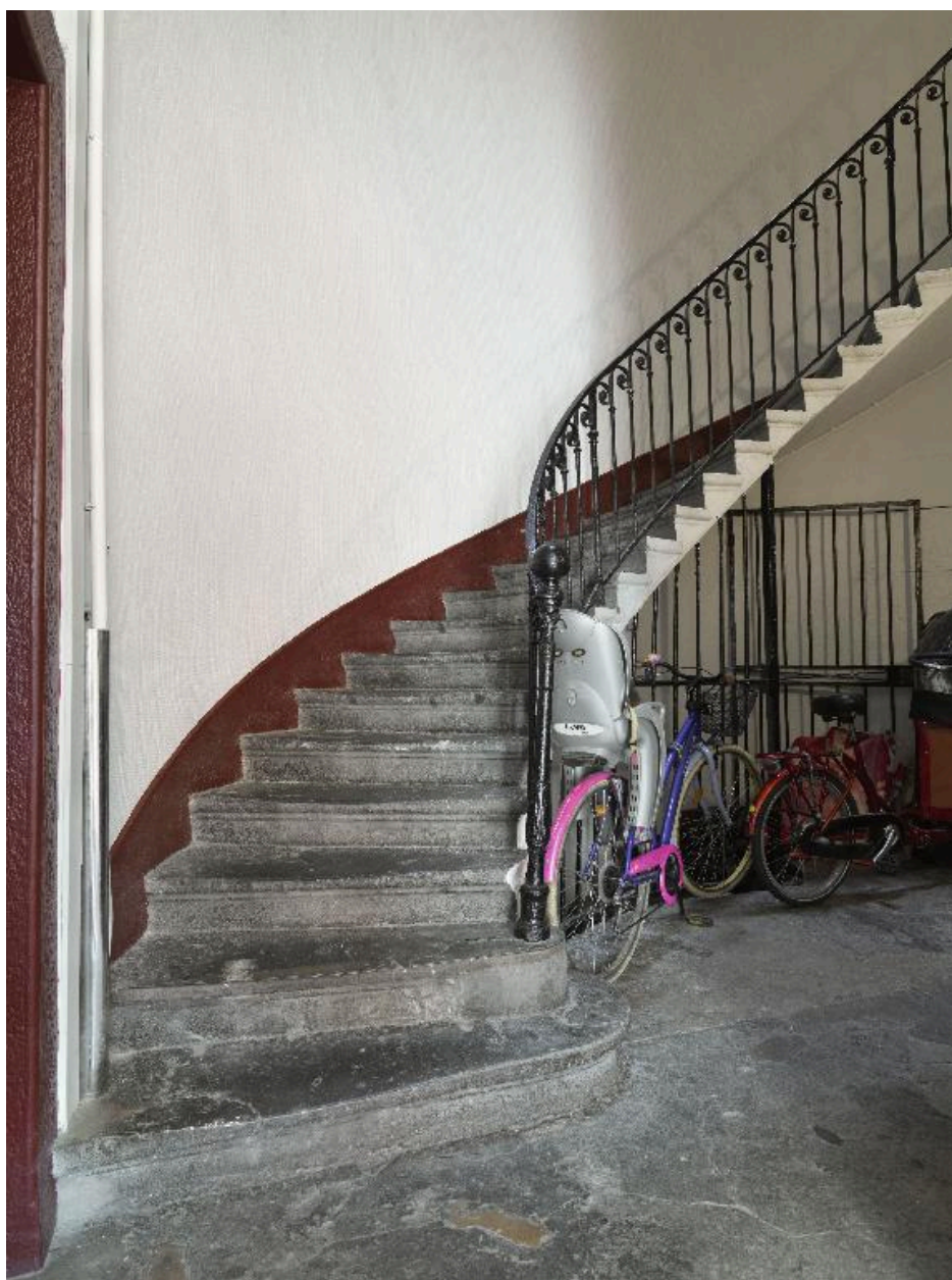
Vue du départ de l'escalier
