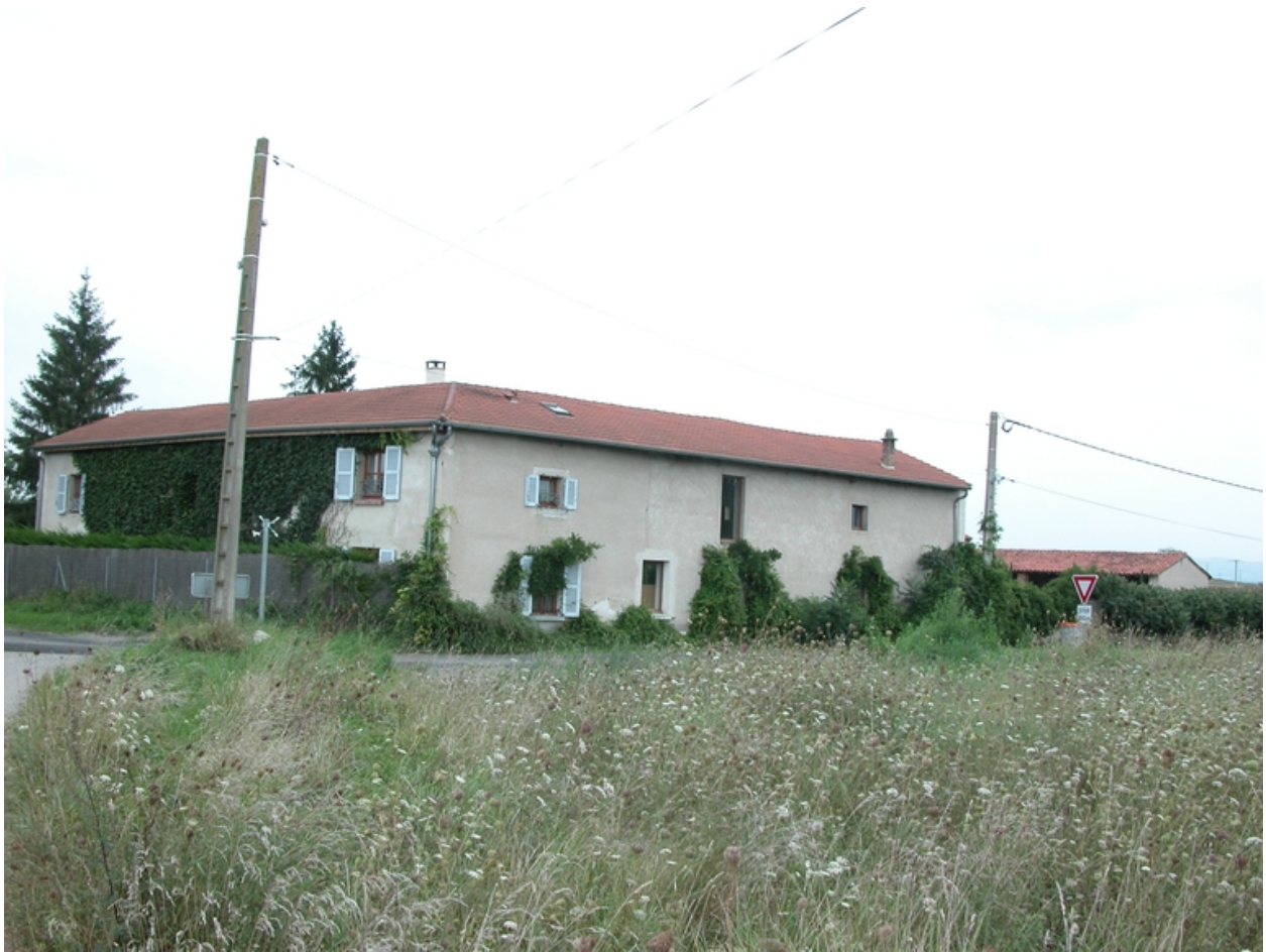
Vue d'ensemble depuis l'ouest (logis, dépendances).
