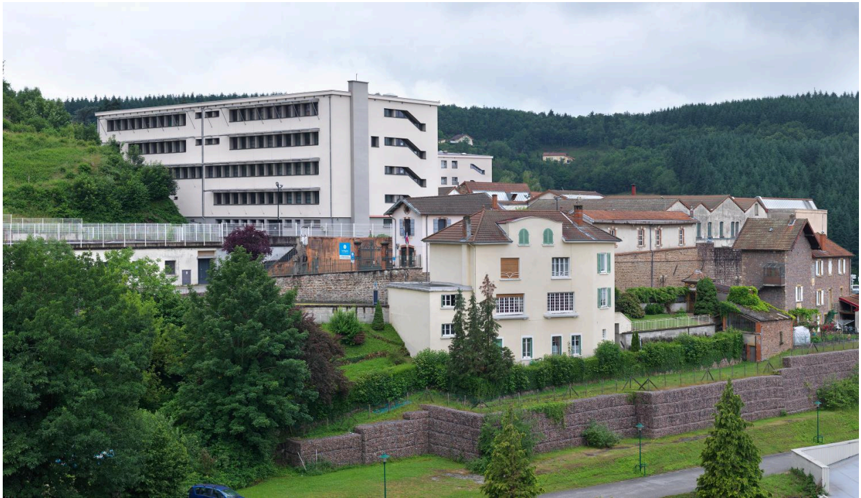
Vue générale depuis le nord-ouest
