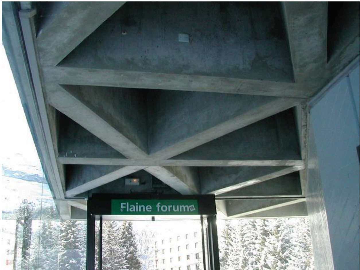
Détail du couvrement de l'entrée
