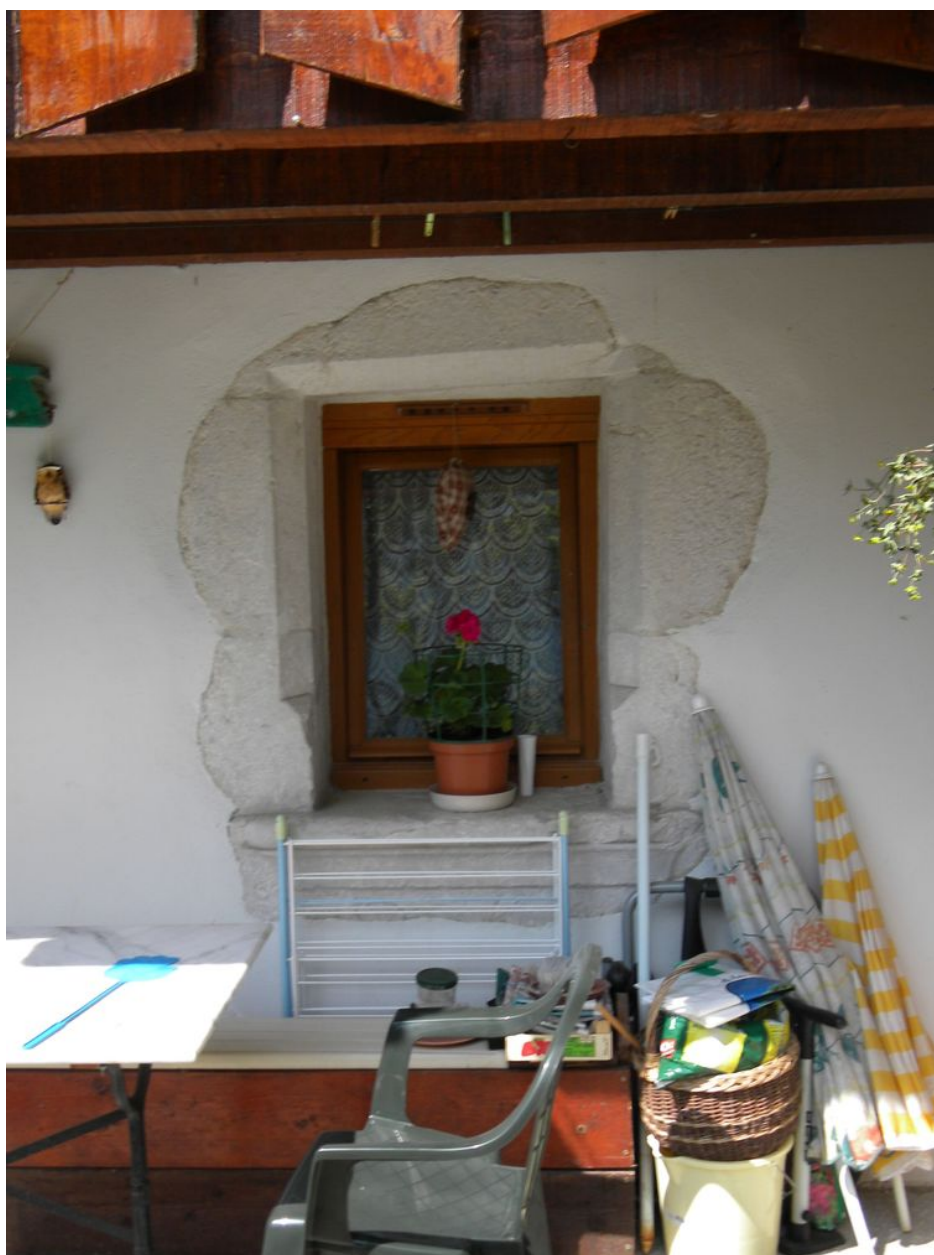
Encadrement de fenêtre chanfreiné sur la façade sud d'une ancienne ferme transformée, datée de 1736 (C5 2107).
