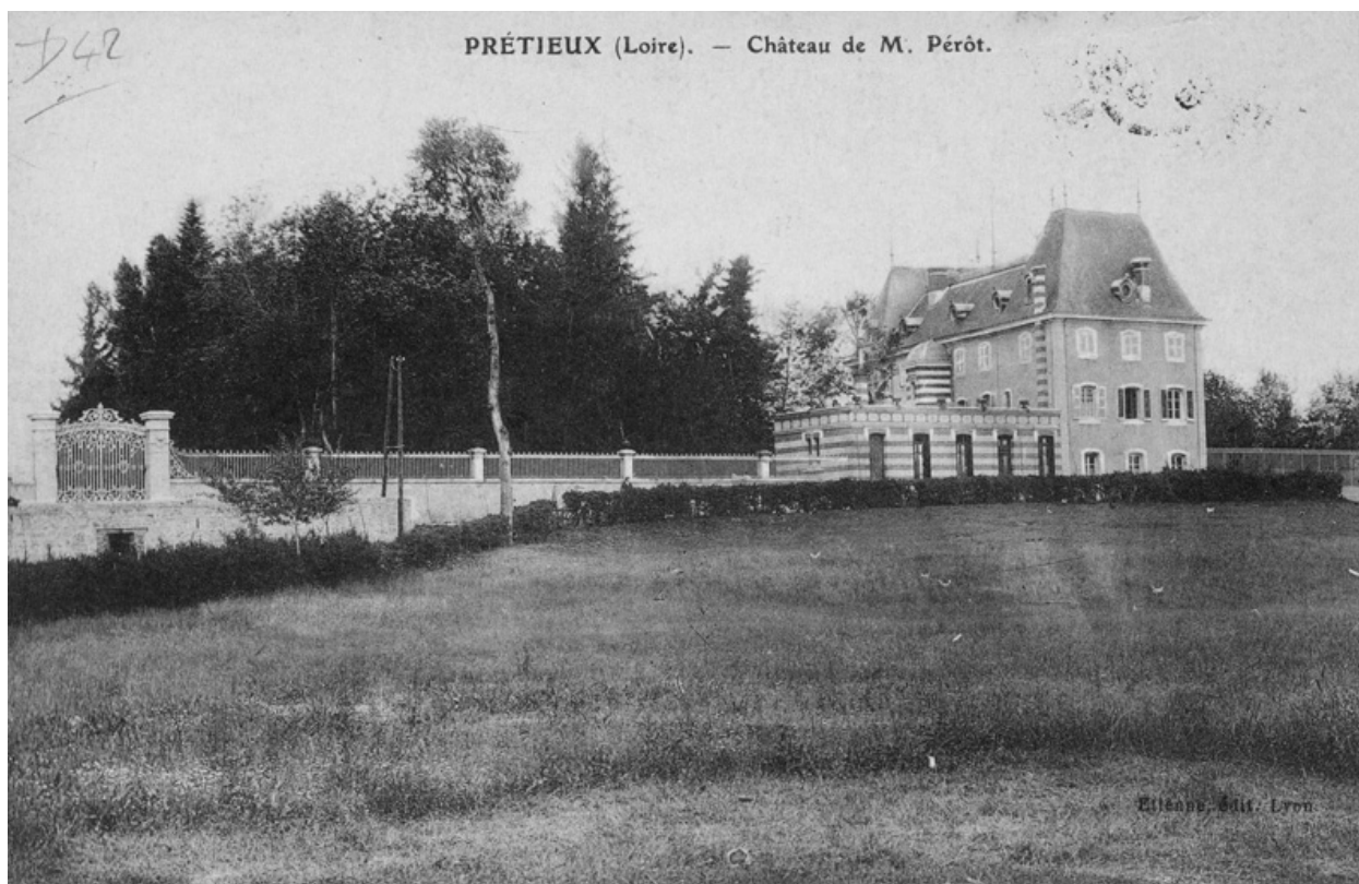
PRETIEUX (Loire) . - Château de M. Pérôt. Etienne, édit. (Lyon). [Vue d'ensemble depuis le sud-ouest].
