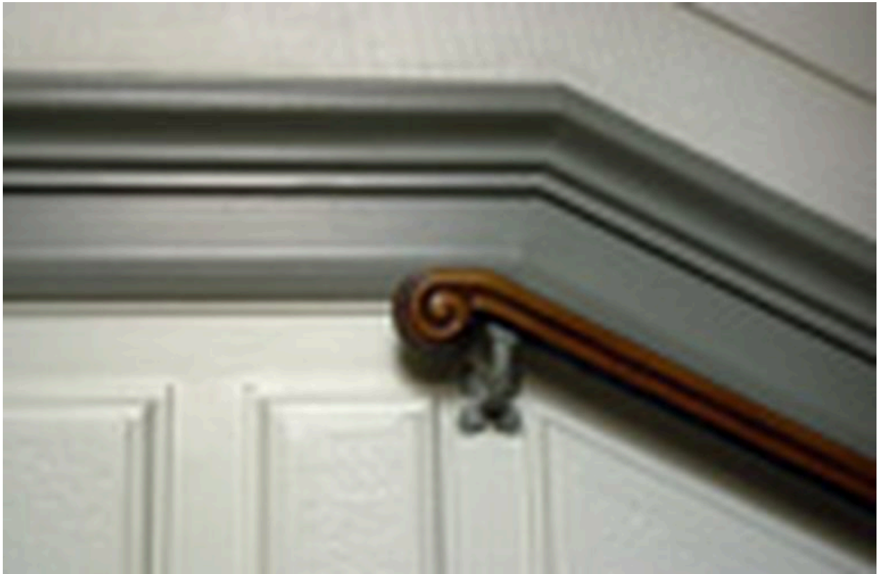
Corps de bâtiment principal, escalier desservant les étages carrés : détail de la rampe d'appui
