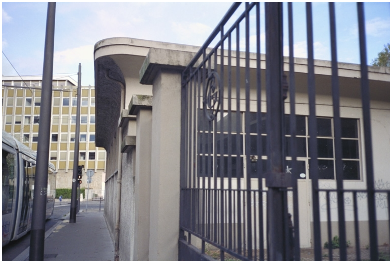
Maison du gardien, détail toiture
