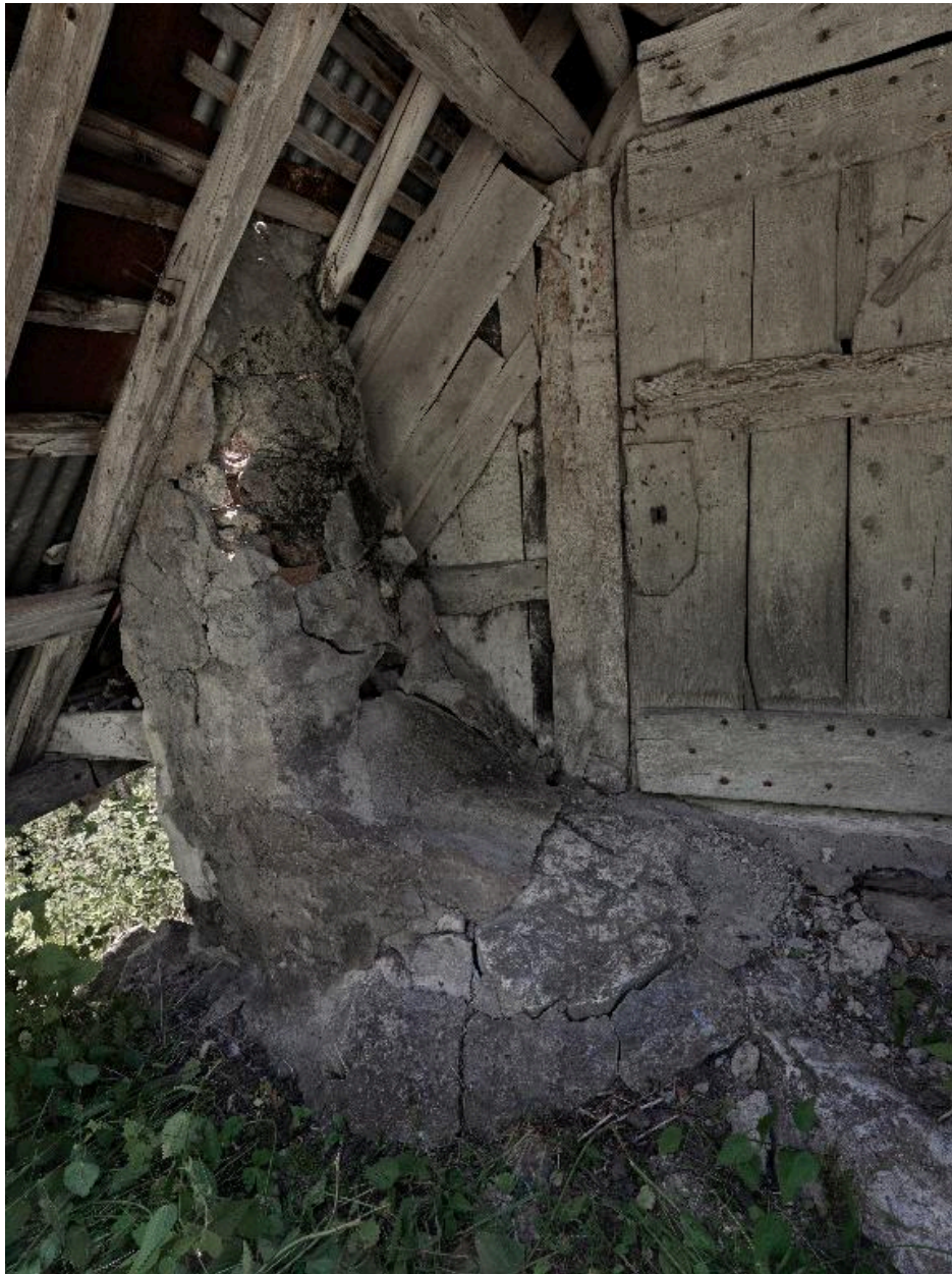
Entrée du fenil et détail du conduit de cheminée en tuf.
