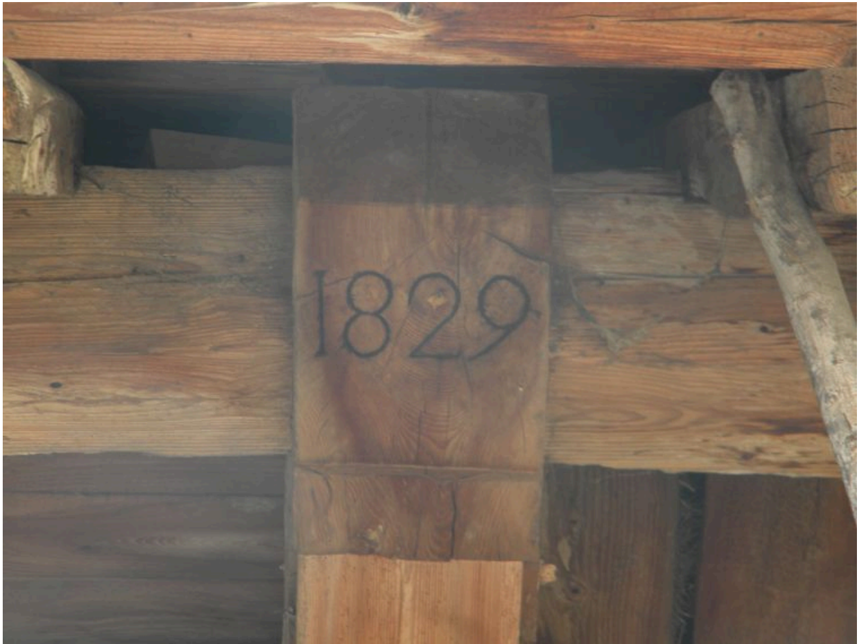
Détail de charpente avec la date 1829 inscrite.
