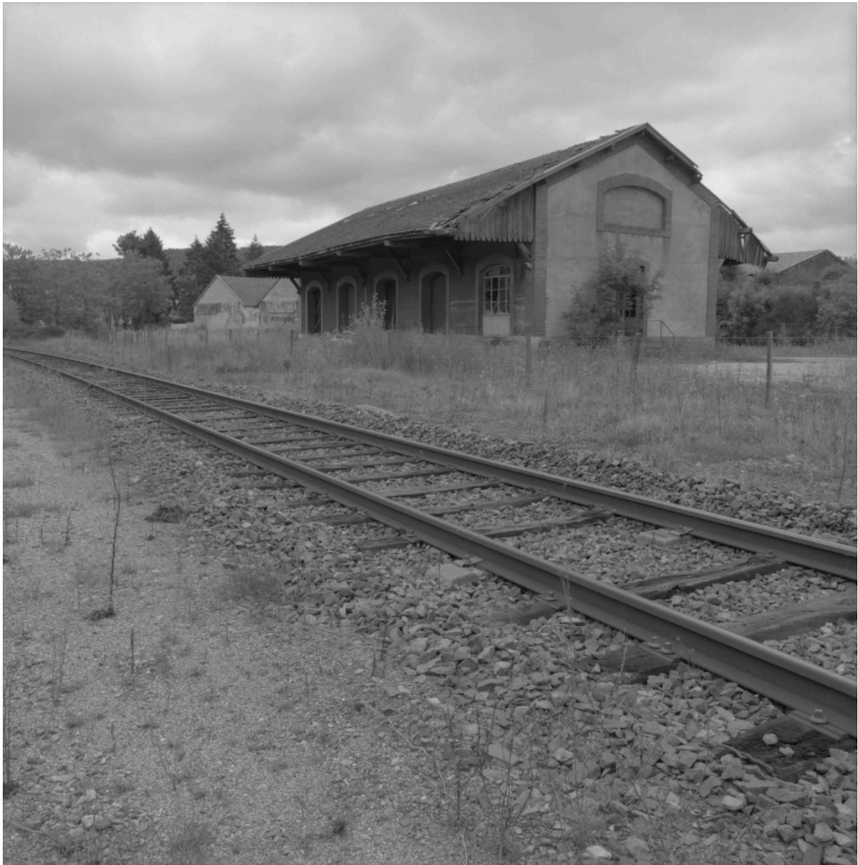
Sail-sous-Couzan, A la Gare, 1986 A 1067. Remise ferroviaire.
