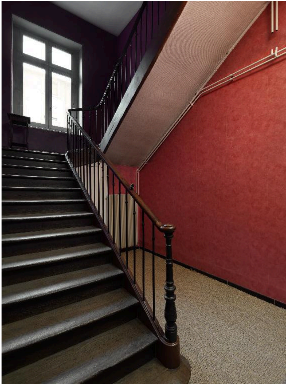
Aile des oratoriens : appartement du 1er étage, escalier intérieur
