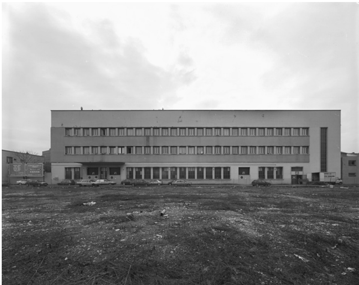
Vue générale nord
