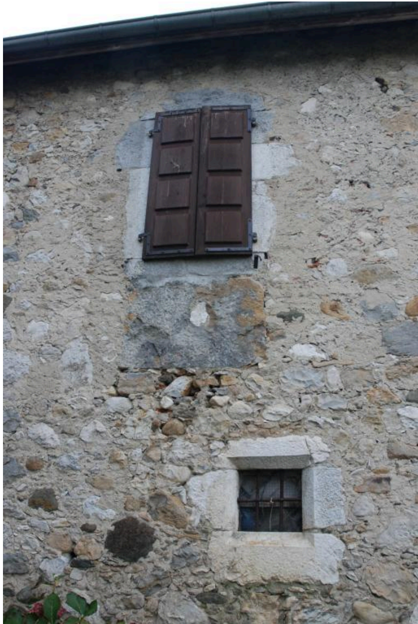
Maison, élévation arrière.
