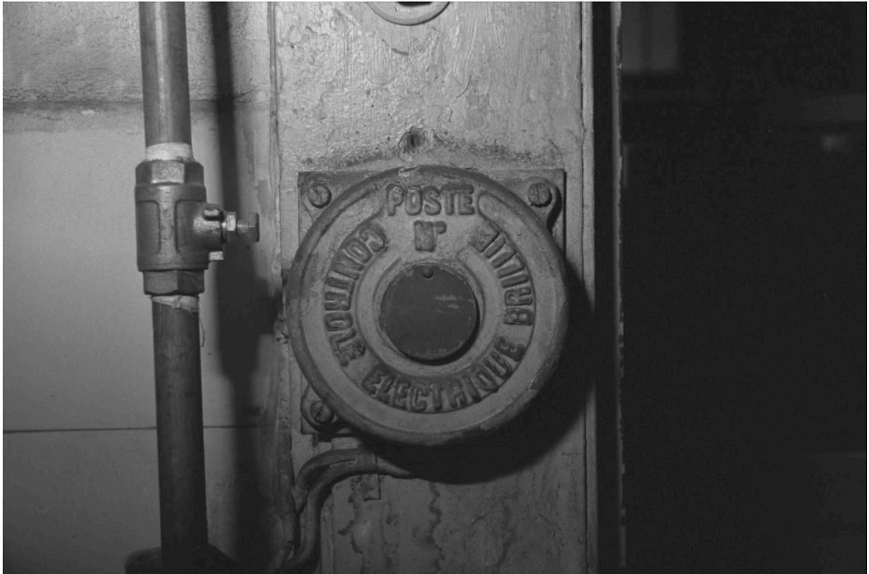
Elément de système des horloges. Bâtiment C, 1er étage, mur nord, à côté de la porte
