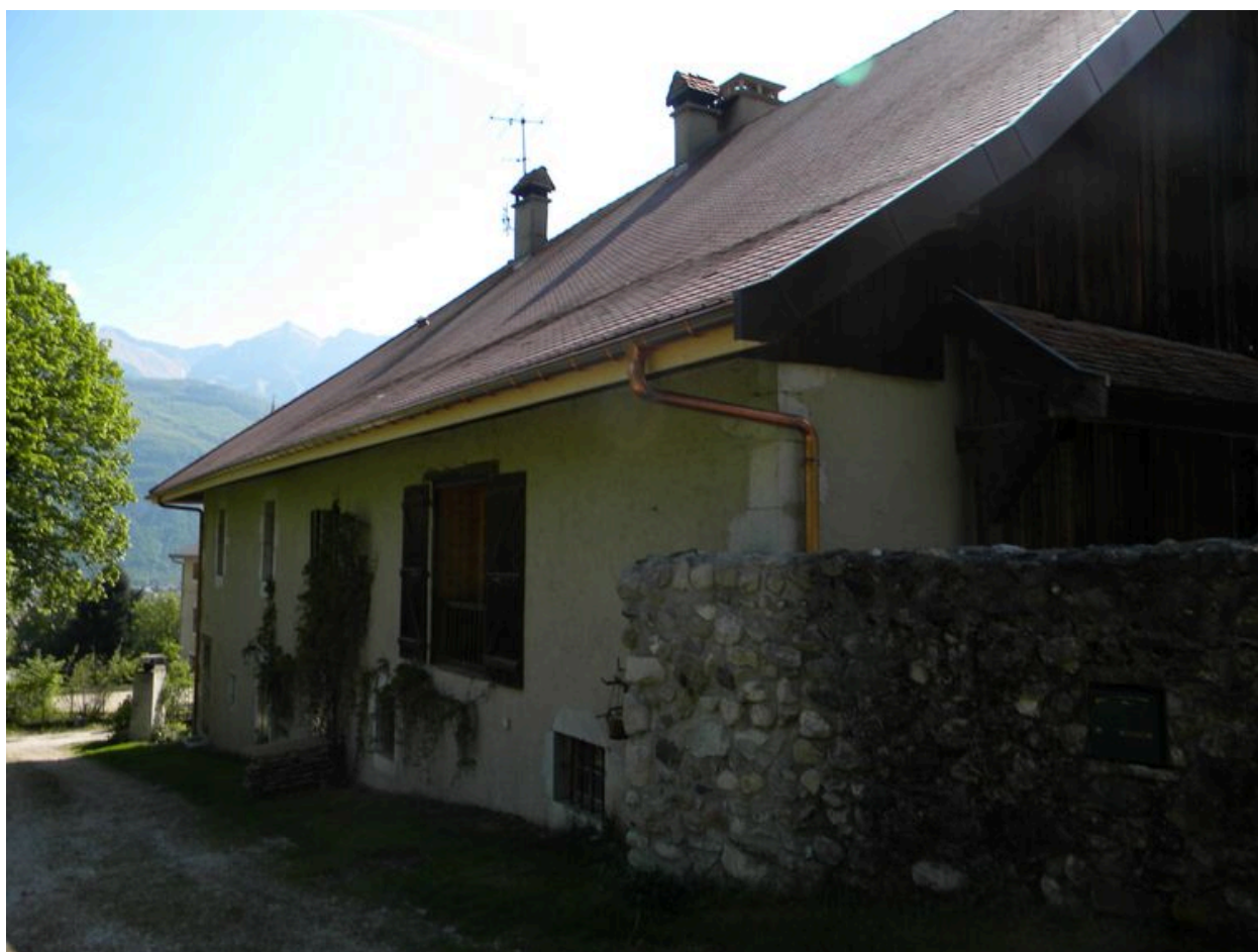
Vue de la façade nord et du pignon ouest.
