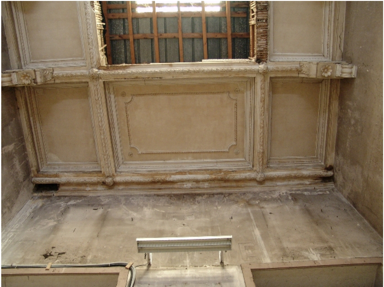
Plafond à décor de stuc, détail
