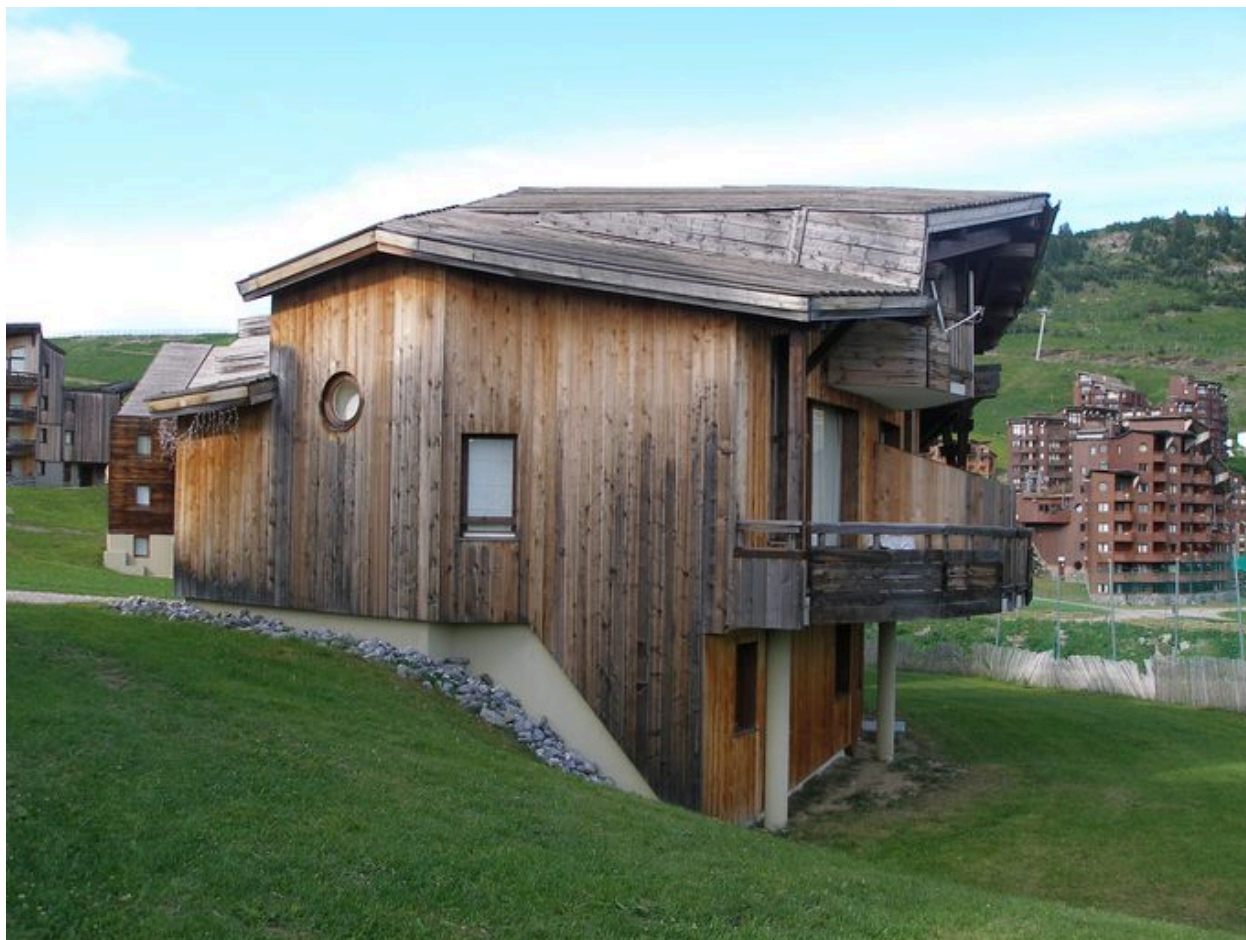
Le pignon sud-ouest
