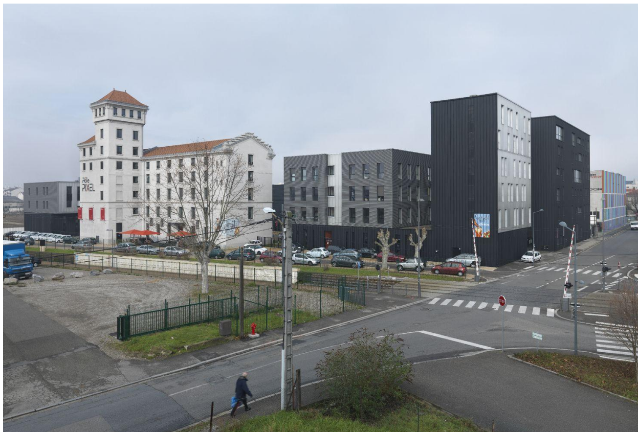
Les Grands Moulins après reconversion
