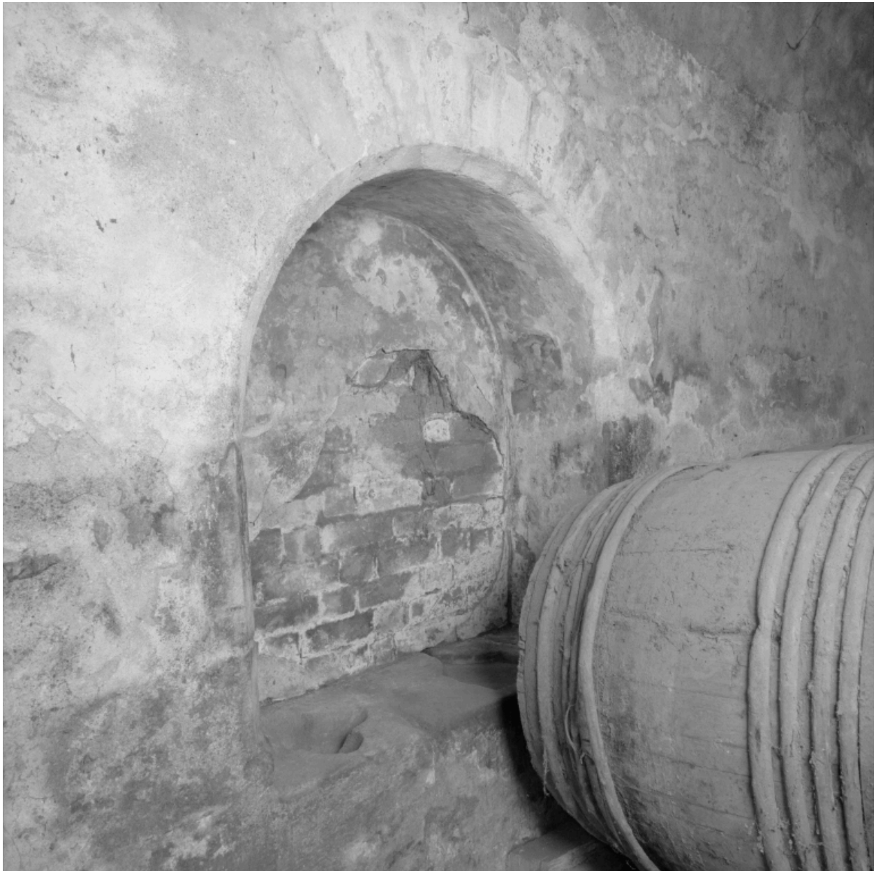
Lavabo situé dans le mur sud de l'absidiole nord.
