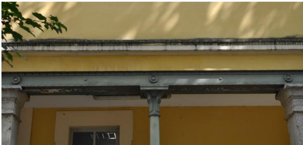
Bâtiment I : détail de l'entablement métallique de la galerie
