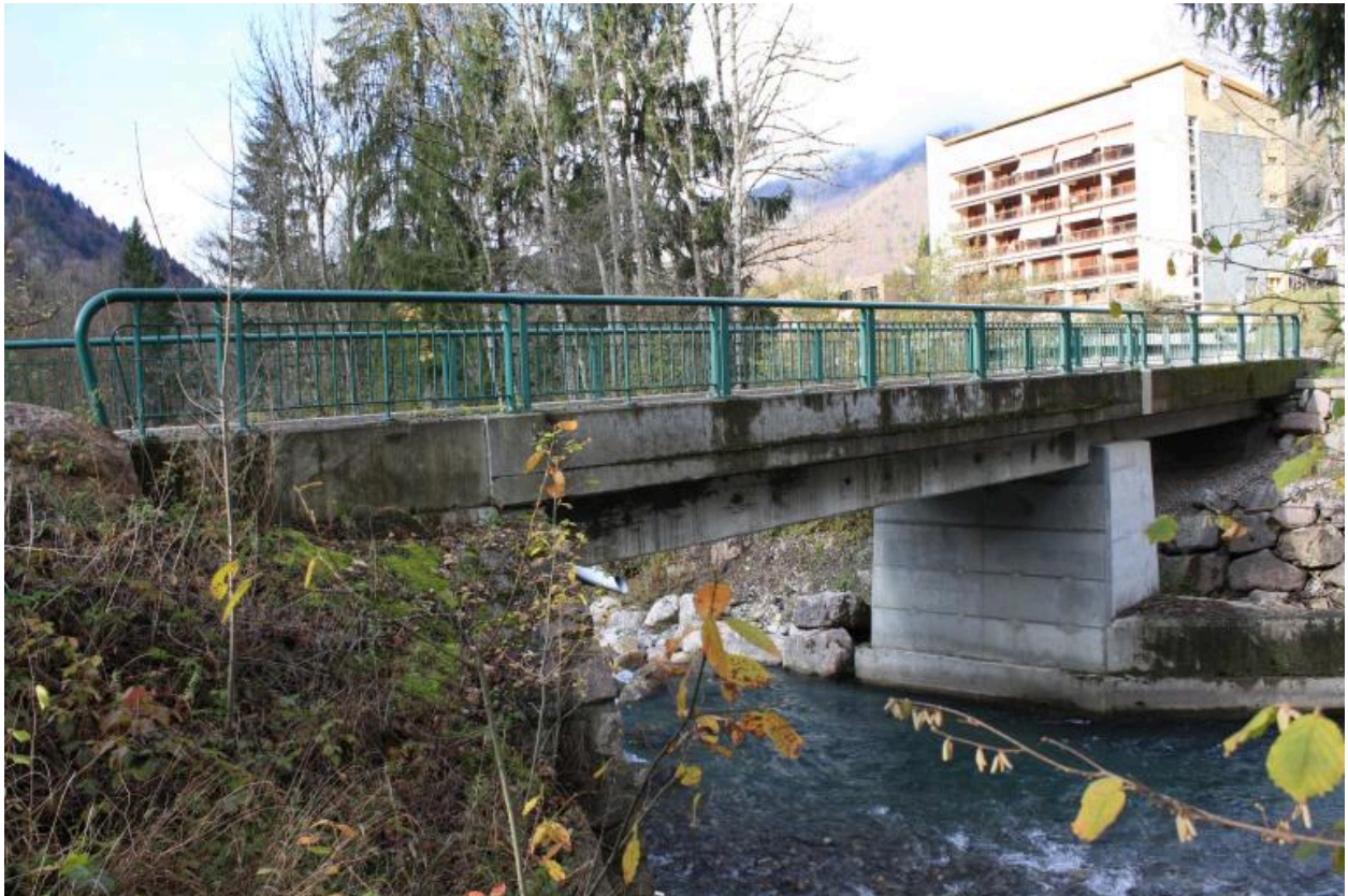
Pond de Sous Saint-Jean, face amont
