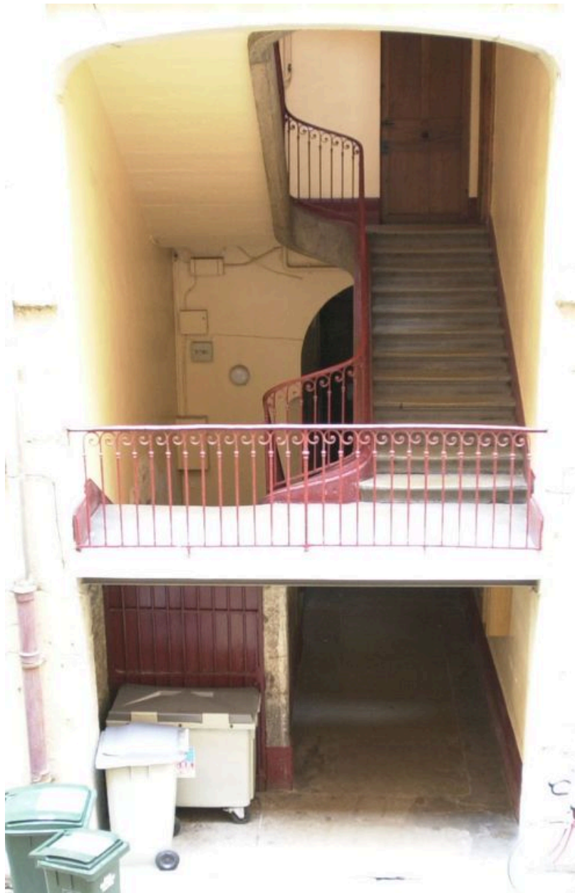
Vue de l'escalier en revers de façade du 14 rue Leynaud
