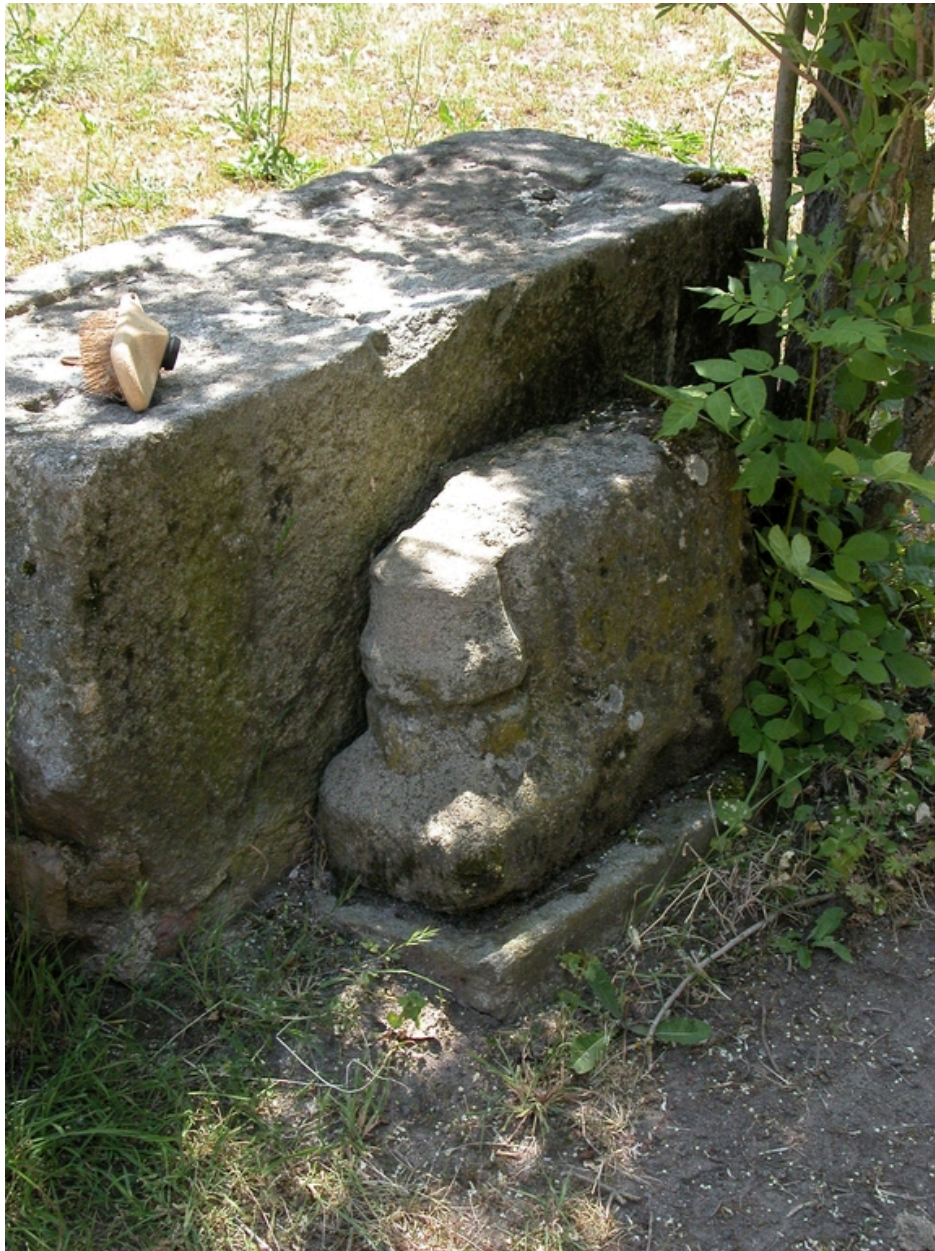
Pierres moulurées déposées dans la cour.
