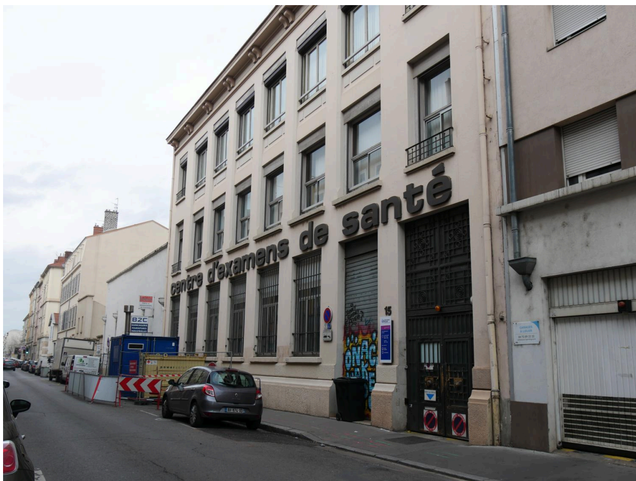
vue d'ensemble façade
