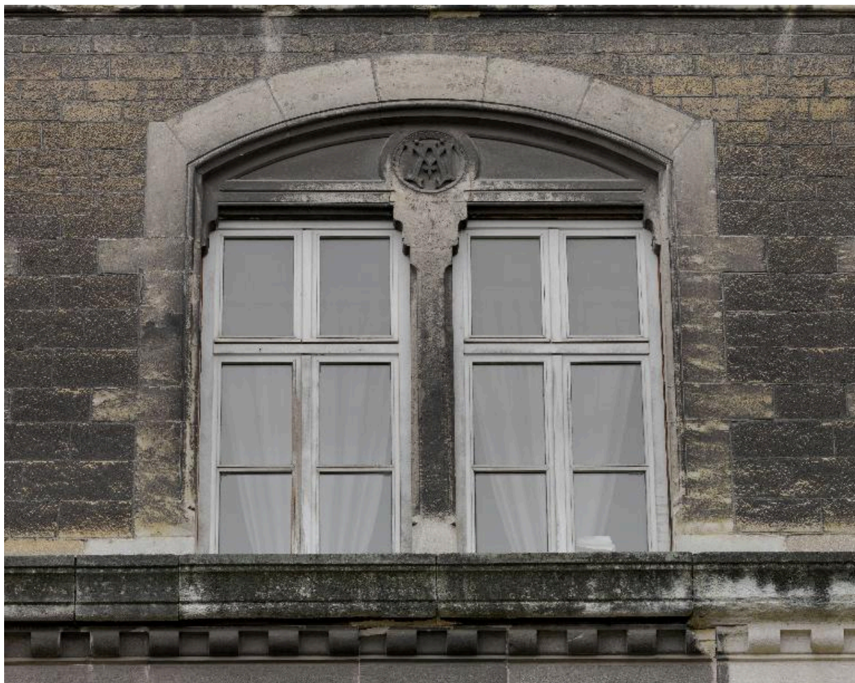
Élévation latérale nord-est, détail d'une baie
