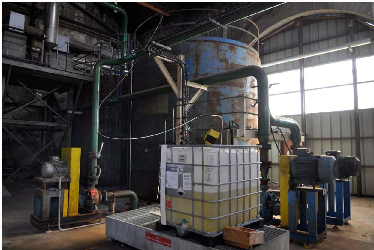
Vue de l'intérieur des ateliers
