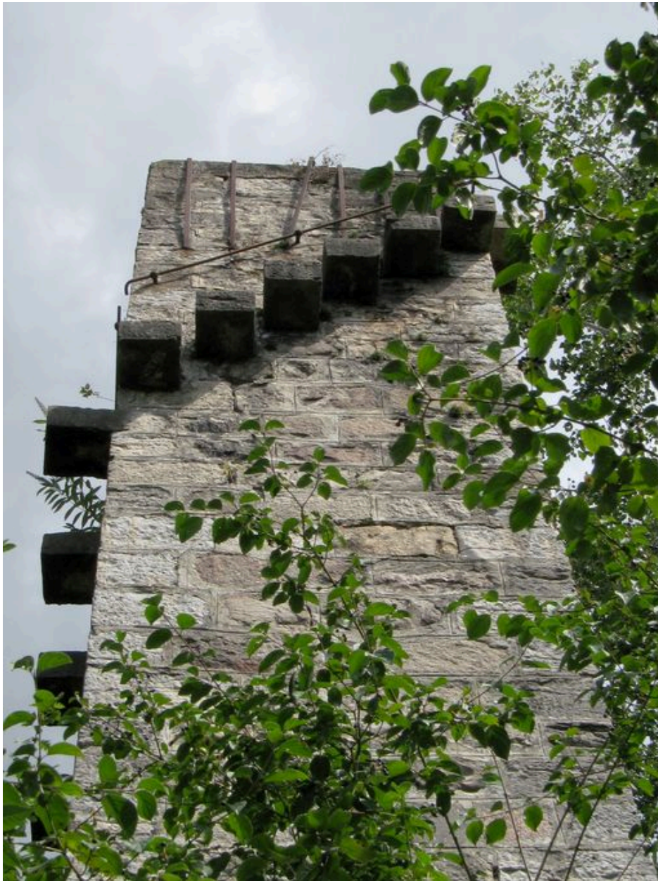
Pile gauche, vue partielle : escalier et main-courante au sommet (depuis l'ouest)
